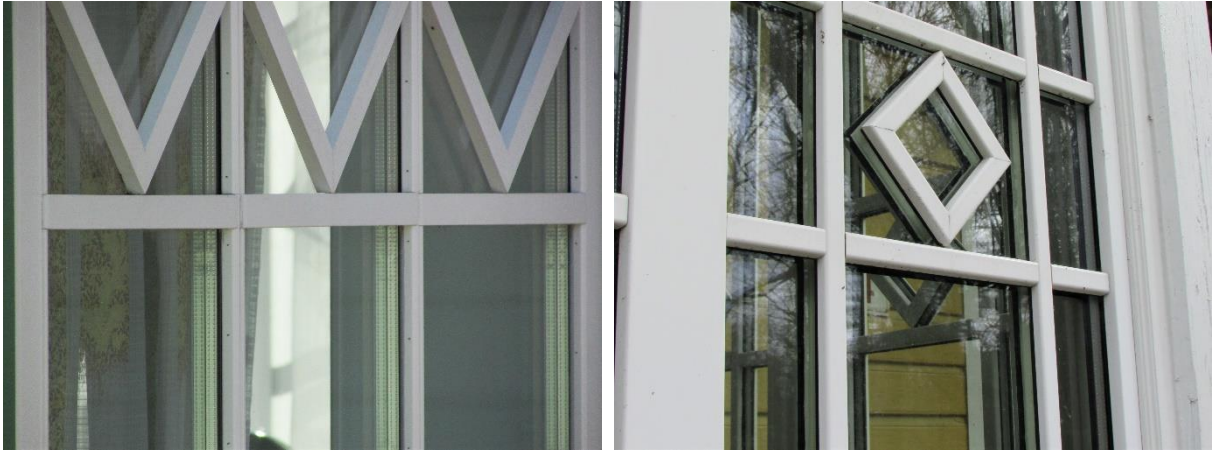
196. Pakettklaas peale kleebitud robustsete liistudega. 197. Pakettklaas peale kleebitud plastikliistudega.
