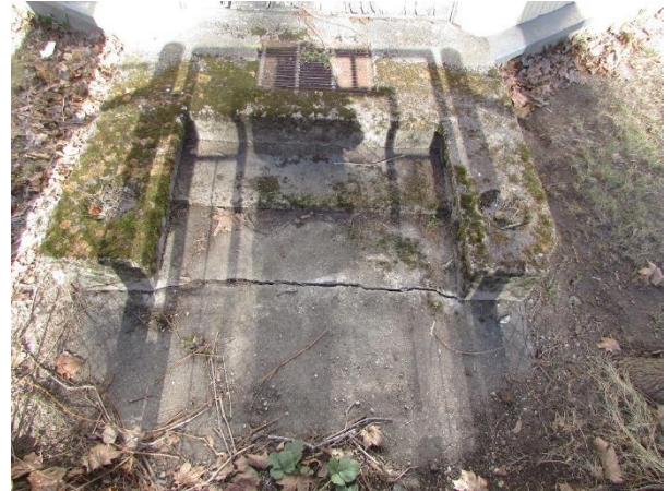
125. Trepil sisse valatud süvised. Rahu 2 Loksal.
