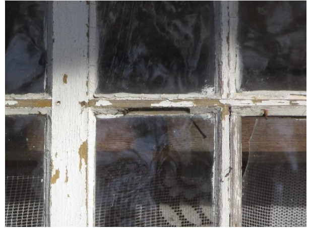
185. Hästi säilinud prosspulgad, pragunenud kitt ja puitliistroostetavate naeltega.
