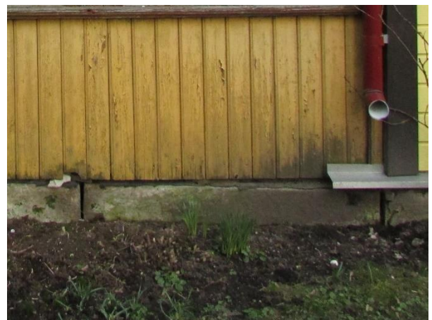
123. Kiviplokid ja tõrvapapist niiskuisolatsioon Allee 4a Kuressaares.
