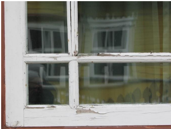
186. Ümar puitliist purunenud, naelad roostetavad.
