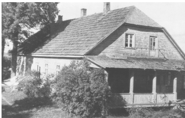
27. Lahtise verandaa Unni talu Rannus Tartumaal.
