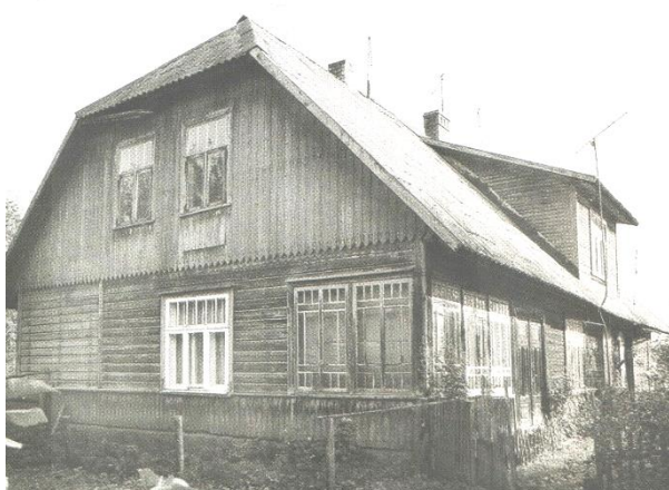
62. Kibe-Toomase talu Viljandimaal.
