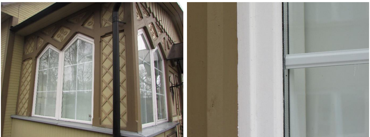
198. Pakettklaaside ja imiteerivate prosspulkadega vera aknad Supeluse 18 Pärnus. 199. Lähivaates Supeluse 18 veranda aken. Puitraamil pakettklaasi vahele paigaldatud imiteeriv plastikust prosspulk.
