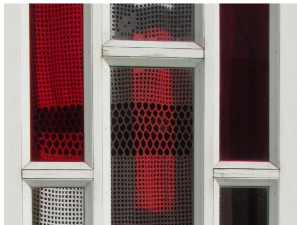
191. Puitliistude ja –prossi vahele tekib vananedes tume triip.
