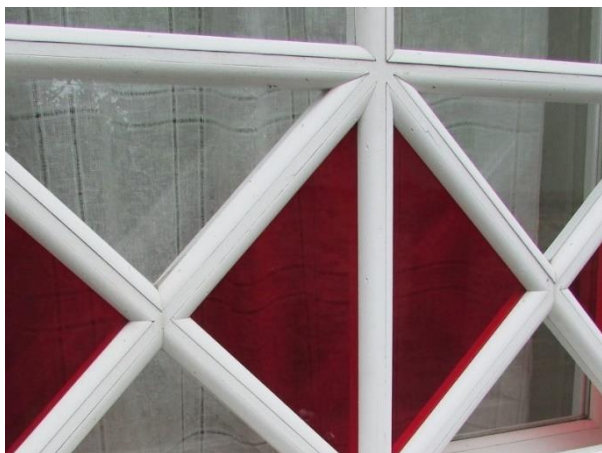
190. Ümara puitliistu kasutamine muudab akna matsakaks.
