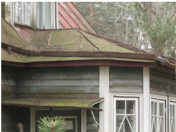
188. Ummistunud sisse valtsitud veerenne ja -süliiti.
