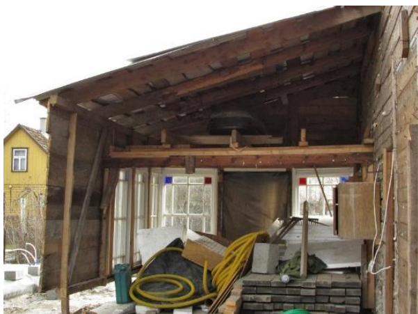
109. Veranda avatud konstruktsioonid ehitustööde ajal.
