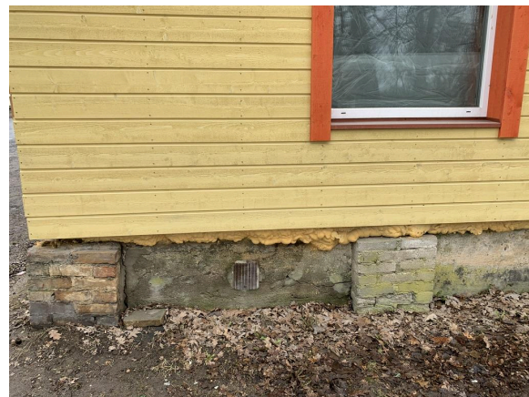
125. Sokli ja seina sõlme on tihendatud ehitusvahuga, kuid sokkel on jäetud viimistlemata. Pikk 29, Järva-Jaani, 2024.
