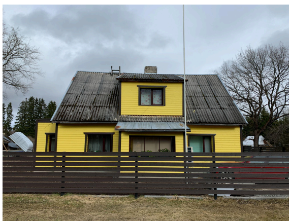
126. Soojustatud ja korda tehtud fassaadiga, kuid vahetamata katusega Pikk 11, Ambla, 2024.
