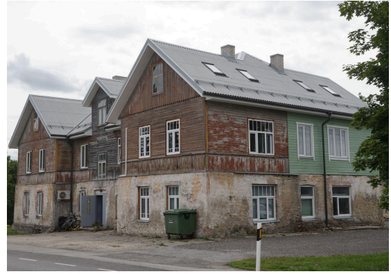
84. Pikk 34, paremas nurgas teisel korrusel ühe korteri piirides ära vahetatud laudis.
