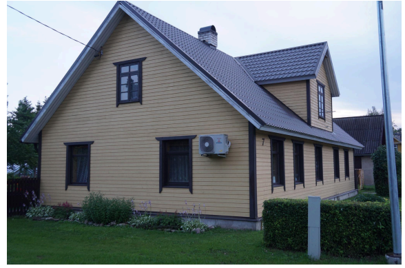
108. Esimese korruse aknad on tagasiastega, katusekorruse aknad fassaadiga samal joonel. Lai 7, Ambla, 2023.
