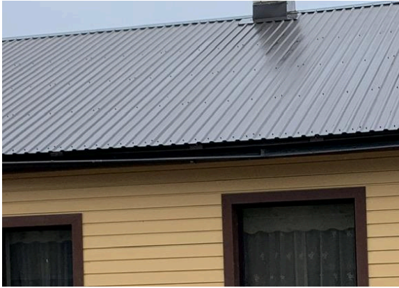
122. Räästakasti külge kinnitatud ripprenn, mille lumi on ära deformeerinud. Pikk 66, Järva-Jaani, 2023.
