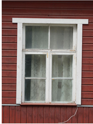
111. Ajalooline T-kujuline puitaken, millel on prosspulkadega jaotused. Pikk 60, Järva-Jaani, 2023.
