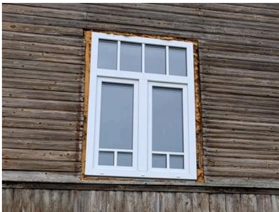
124. Pärast uue plastakna paigaldamist on akna ümbruses olnud vahed ehitusvahuga täidetud ning ilmastikutingimuste käte jäetud. Pikk 34, Järva-Jaani, 2024.
